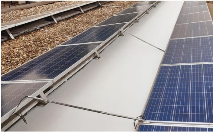
Bei vielen Modulen sinkt pro Grad Celsius mehr an Eigentemperatur die Energie-Ausbeute um 0,35%. Das klingt erst einmal nicht viel, doch bei 10°C Temperaturunterschied sind das bereits 3,5% weniger erzeugte Energie.
