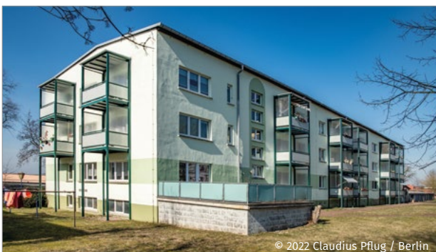
Wohnblöcke in Karstadt und Perleberg, Deutschland. Fassadenbeschichtung von 28 Wohnblöcken, 1998 bis 2009.
